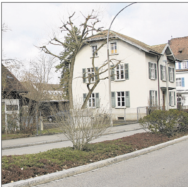
Dieses Haus will die Gemeinde für die Garageneinfahrt und einen Neubau abreißen.
