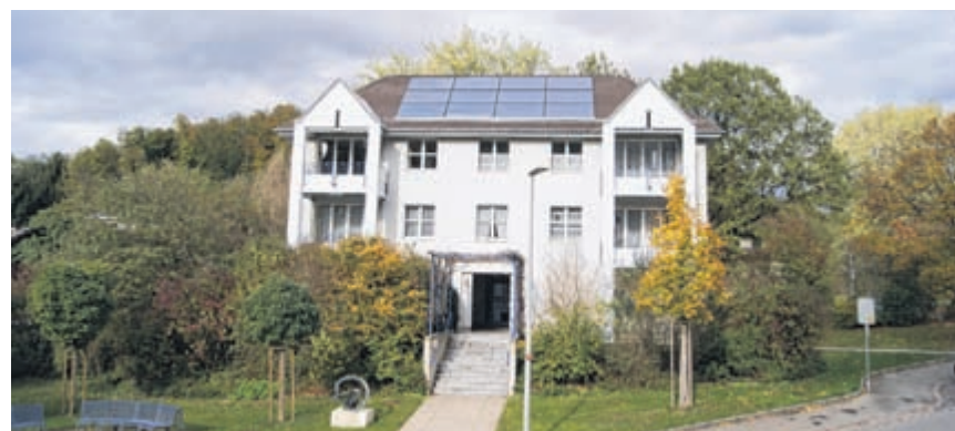
Das ehemalige Postgebäude in Bettingen verfügt über eine Solaranlage zur Brauchwassererwärmung, die auf dem Dach installiert wurde.
